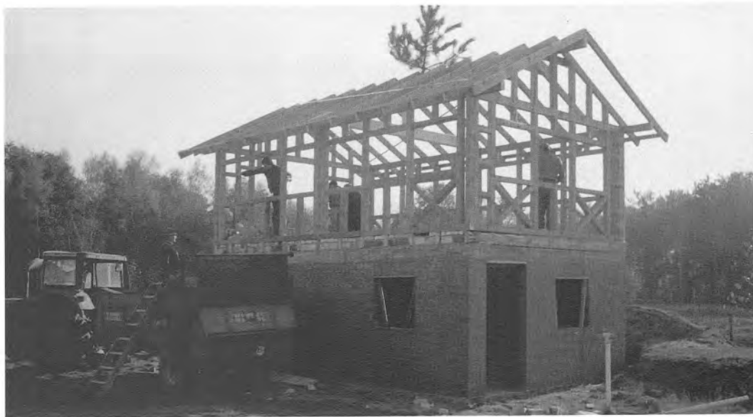
Herbst 1988: Der Bau des Richterhauses schreitet gut voran.
